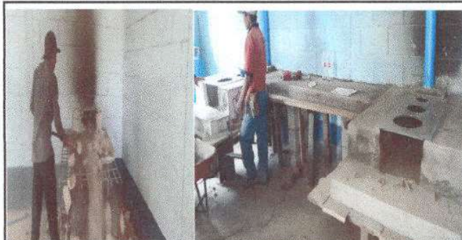
Foto 6: REMOZAMIENTO DE ESTUFAS Y MESA DE CONCRETO DE 2 METROS
