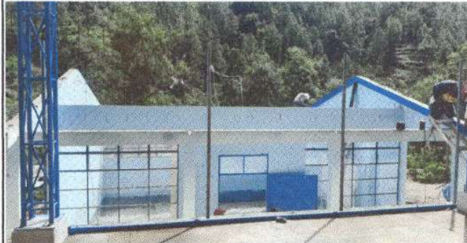
Foto 2: CAMBIO DE ESTRUCTURA
