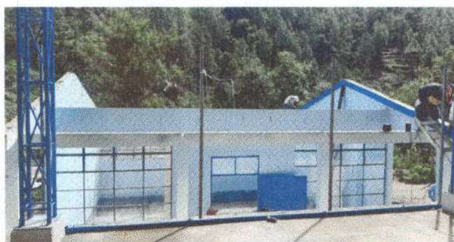
Foto1: CAMBIO DE TECHO
