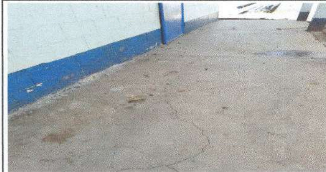
Foto 4: REMOZAMIENTO DE BANQUETA
