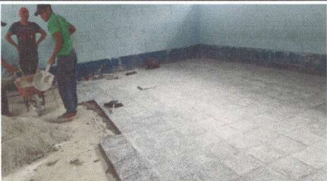
Foto 3: REMOZAMIENTO DE PISO A GRANITO
