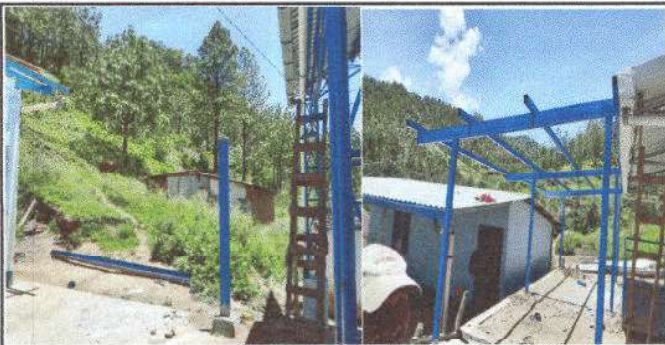
Foto 5: COMPLEMENTO DE TECHO Y ESTRUCTURA DIRECCIÓN, BODEGA Y MODULO DE PREPRIMARIA
